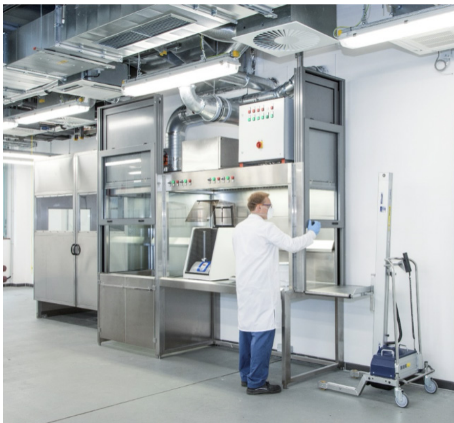
Imagen 1: Cabina de extracción de contaminantes en industria farmacéutica.
